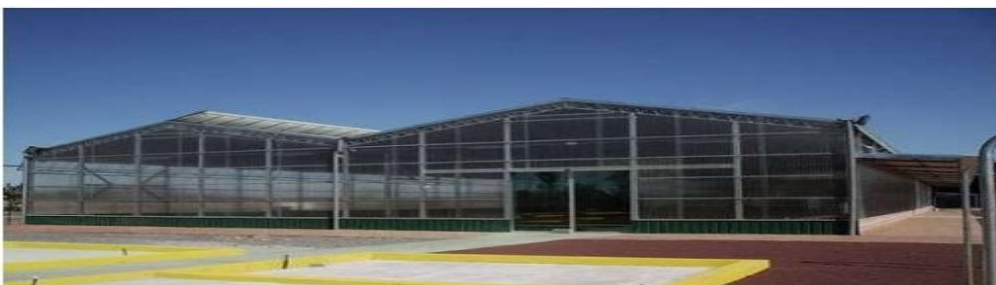
Figura 6 Invernadero de capilla.
