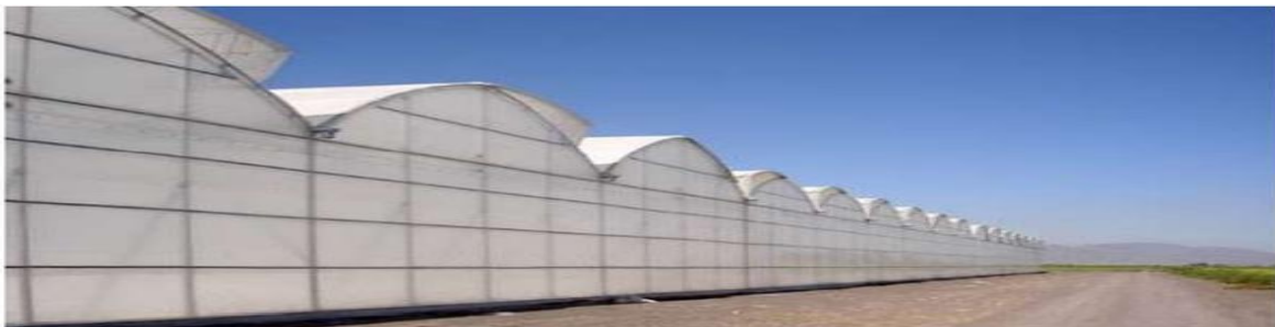
Figura 10 invernadero con techumbre curva.
