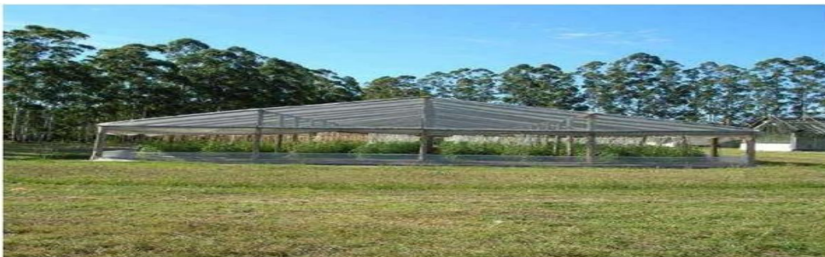
Figura 5 Invernadero de capilla a dos aguas.
